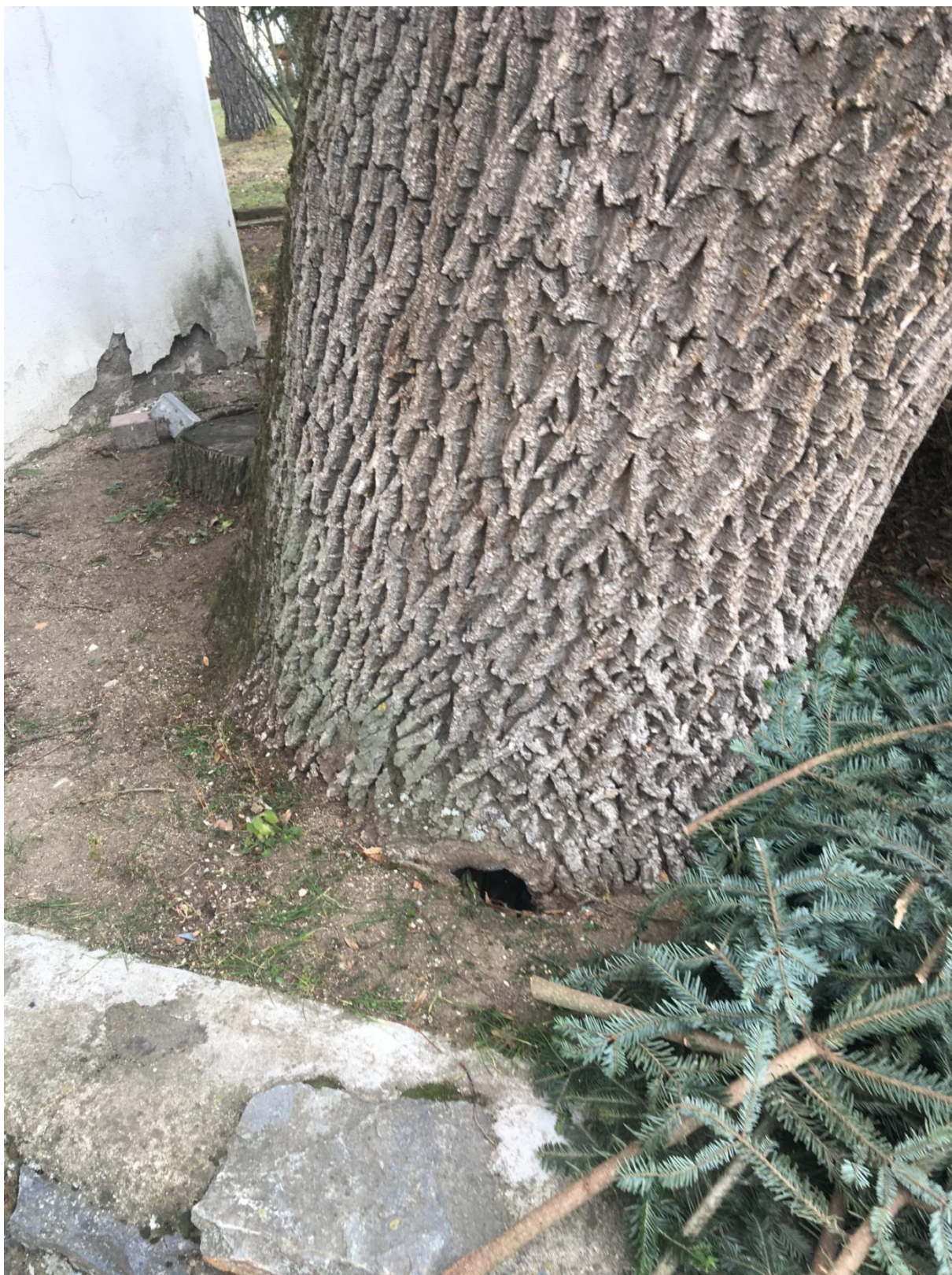
Obr. 7: strom ev.č. 18. vstup do rozsáhlé centrální dutiny v bazální a kořenové části hodnoceného stromu.
